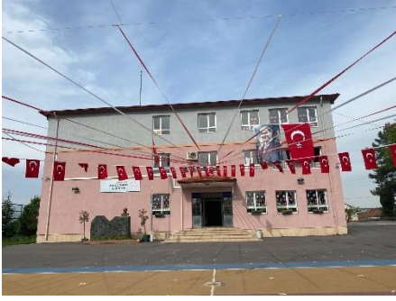
Resim 1 Gündoğdu İlkokulu Binası
